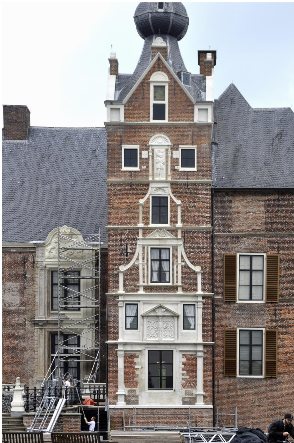
Het schilderwerk van de natuursteen is uitgevoerd met een speciale kalkverf.
