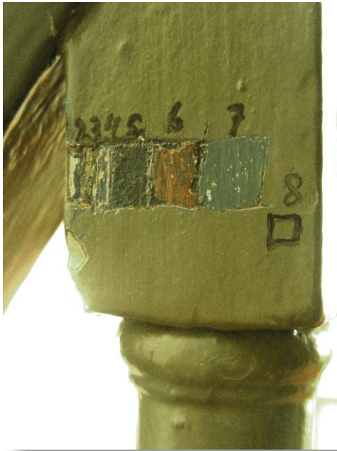
Kleuronderzoek op trapbaluster, rechts het microscoop-preparaat: er blijken ruim 12 lagen te zijn; een kleurtrapje brengt niet altijd alles aan het licht!
